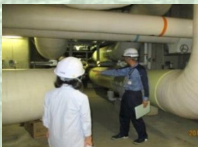
地下専用溝内の配管
